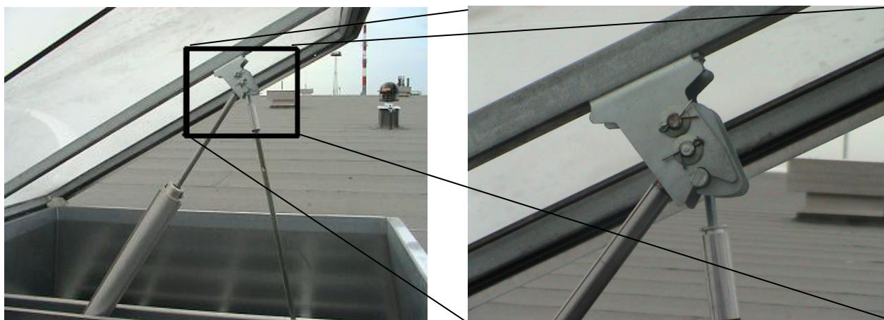
Rys. 24 Połączenie siłowników z konsolą hakową.
